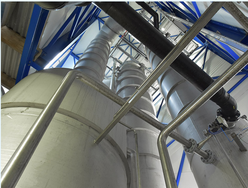
Moderniseringen i Hanstholm, der bl.a. omfatter denne nye inddamper set fra gulvplan og 12 meter op, betyder samtidig, at kapaciteten i dag udnyttes fuldt ud med optimeret drift og styrket kvalitet.
